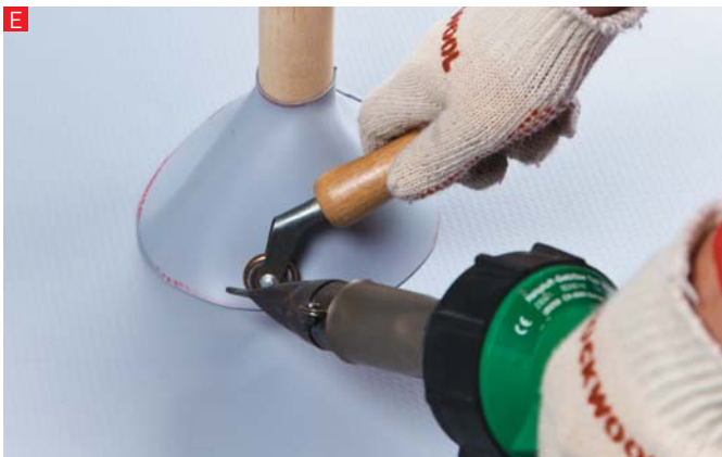
Г. Разогреваются внутренняя и внешняя кромки конуса.
