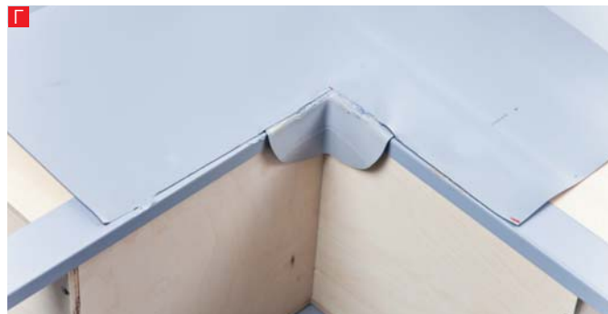
Г. Сверху на профили из ламинированной ПВХ-жести наваривается мембрана ROCKmembrane.
