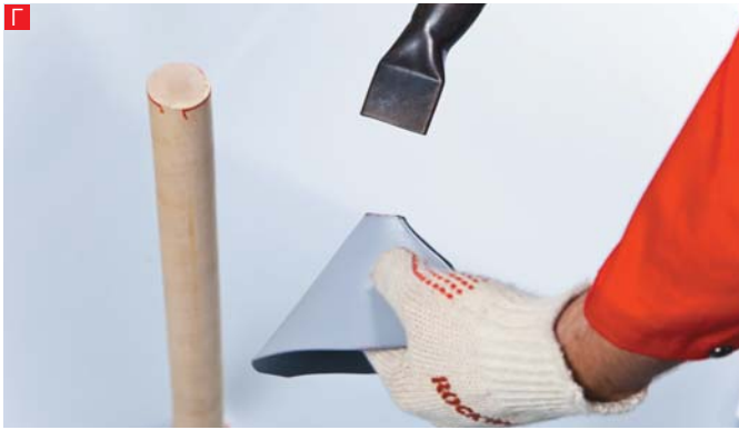
Г. Разогреваются внутренняя и внешняя кромки конуса.
