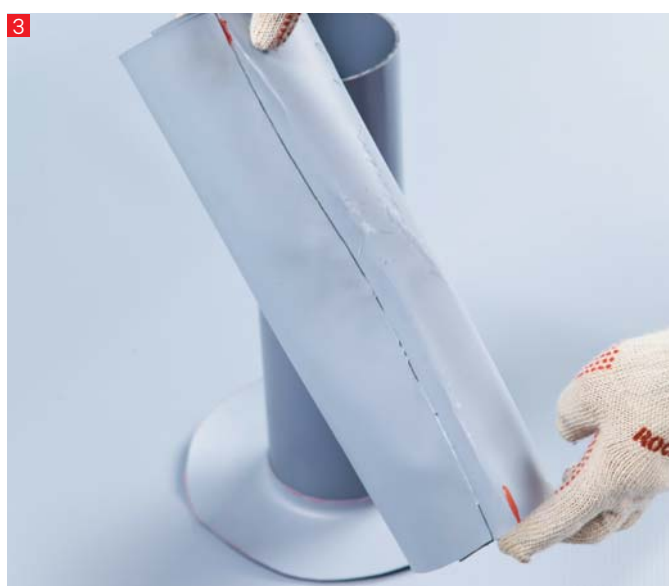
З. И растягивается вручную.
