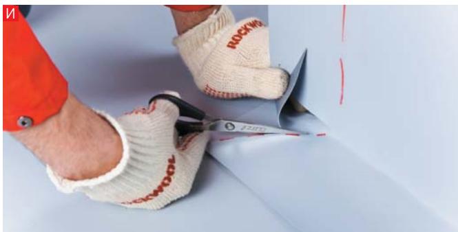
И. Наконец, провариваются горизонтальные поверхности.
