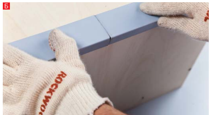
Б. Следующий прямой сформированный профиль из ламинированной ПВХ-жести крепится на внешней стороне парапета со стороны фасада с интервалом от уже закрепленного. Интервал выбирается в зависимости от длины жести, равный 2 мм, на каждый погонный метр ПВХ-жести.
