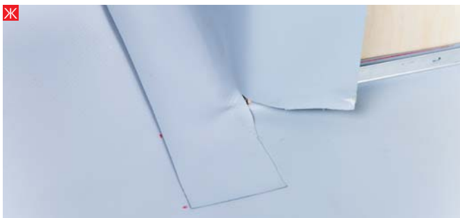
Ж. Затем провариваются вертикальные соединения мембран.
