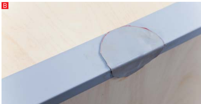
В. Стык между профилями из ламинированной ПВХ-жести заваривается полосой неармированной ПВХ-мембраны ROCKmembrane, шириной около 20 см.
