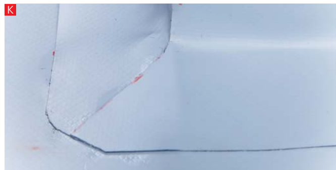
К. Полностью изолированный внешний угол плоской кровли.
