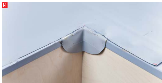
Е. Внутренний угол профиля из ламинированной ПВХ-жести на парапете со стороны кровли заваривается полосой из неармированной ПВХ-мембраны ROCKmembrane шириной около 20 см.
