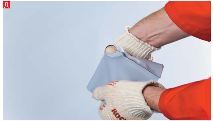
Д. И пока не остыла мембрана натягиваются на изолируемый проход.
